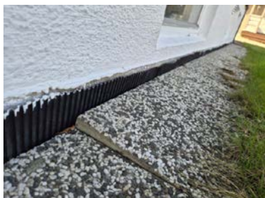
Grunnmursplast glidd ned fra pusslag.
