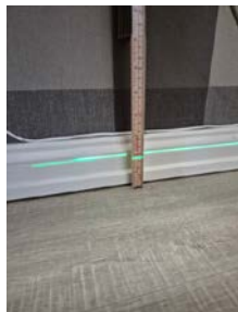
Målt fra 4,4 cm mot yttervegg...
