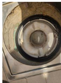
Plastsluk med synlig membran
