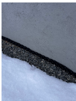
Grunnmursplast som utvendig fuktsikring, synlig enkelte steder.
