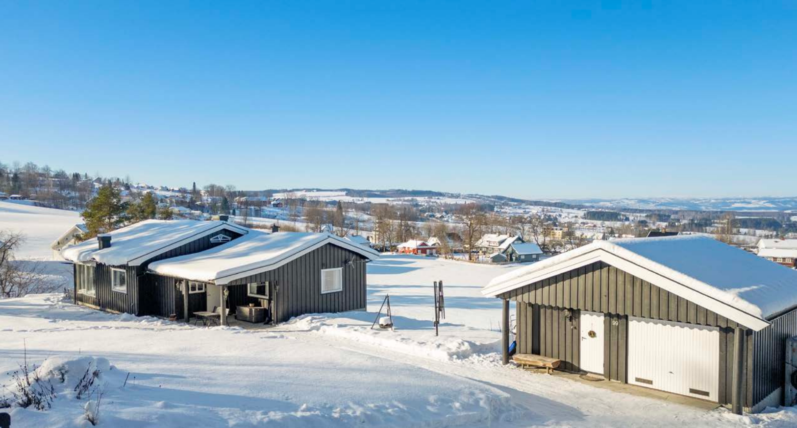
Garasje på eiendommen.
