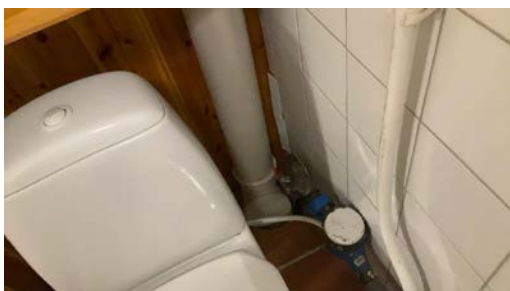
Avløpsrør i plast.
