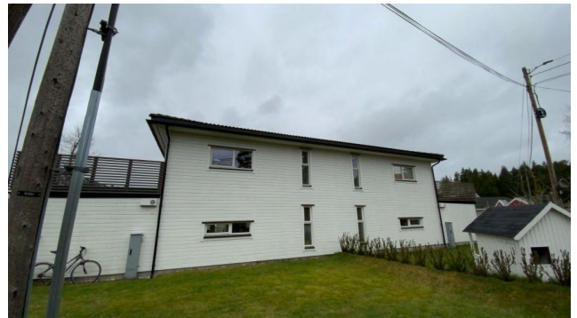
Besiktigelse av taktekke.
