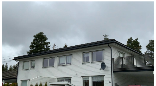
Besiktigelse av taktekke.
