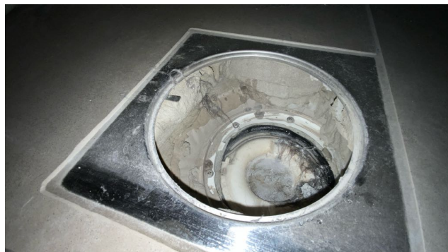
Kontroll av sluk.
