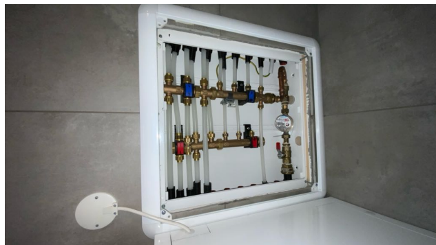
Besiktigelse av røropplegg.
