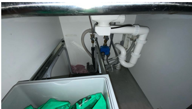
Besiktigelse av røropplegg.
