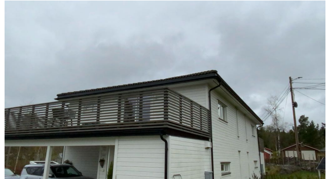
Besiktigelse av taktekke.
