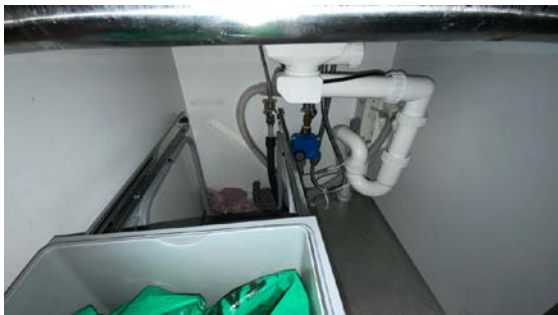
Besiktigelse av røropplegg.
