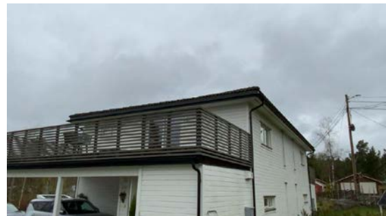
Besiktigelse av taktekke.
