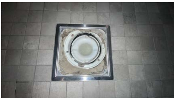
Kontroll av sluk.
