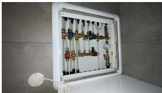
Besiktigelse av røropplegg.
