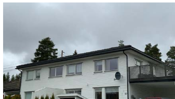
Besiktigelse av taktekke.
