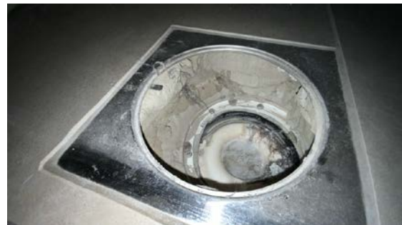
Kontroll av sluk.
