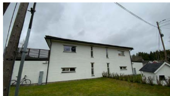
Besiktigelse av taktekke.
