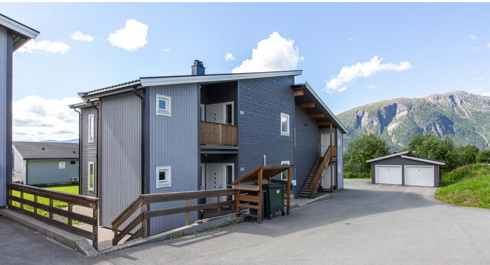
Fasade fra vei og parkeringsområde, samt garasje til høyre i bildet.
