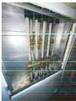
Vannmåler og stoppekran på teknisk rom.
