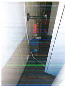
Vannmåler og stoppekran på teknisk rom.
