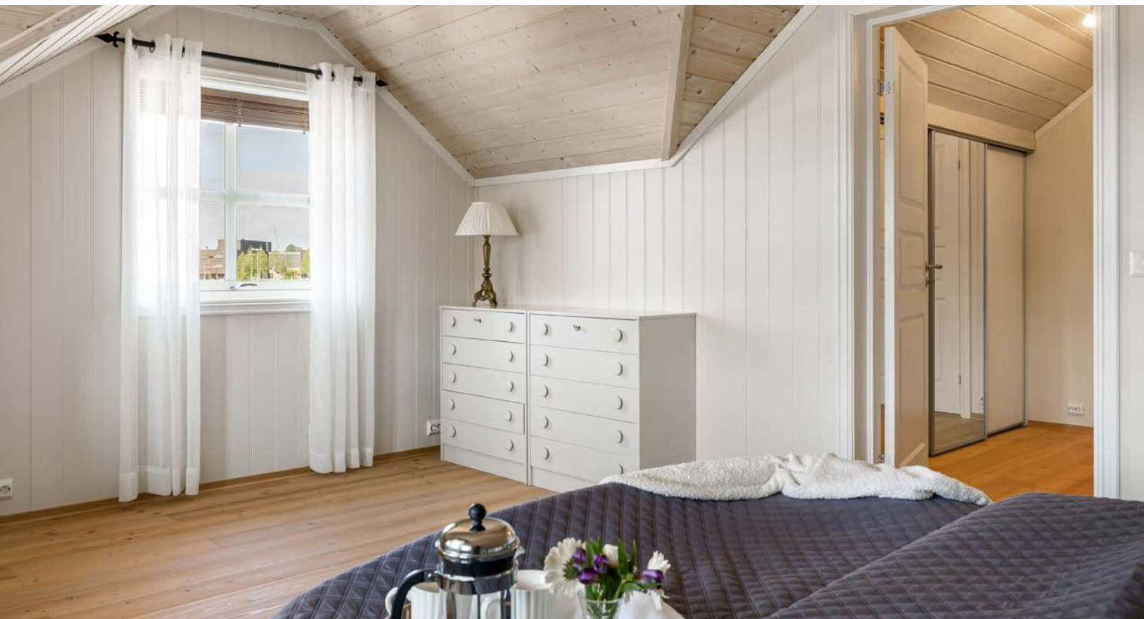
Rommet har parkett på gulvet, malte veggoverflater og beistet himling.
