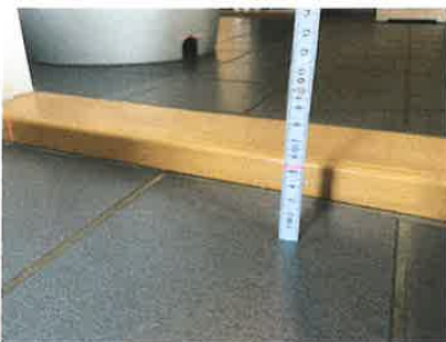
Høyde gulv ved dør mot teknisk rom.
