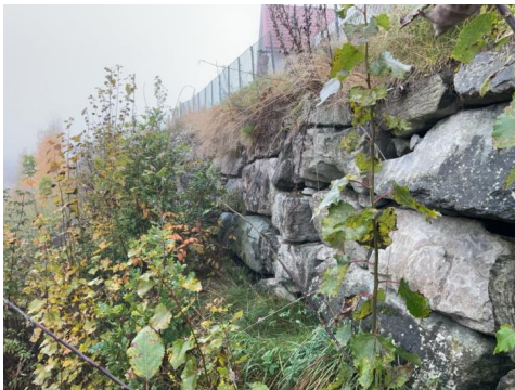
Støttemur i naturstein.
