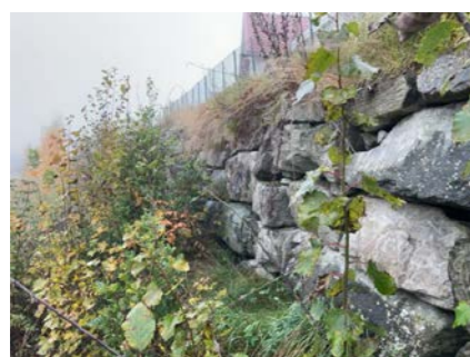
Støttermur i naturstein.
