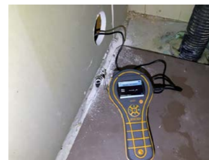
Fuktmåling i konstruksjon mot bad.
