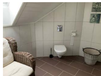
Bad med veggmontert toalett.
