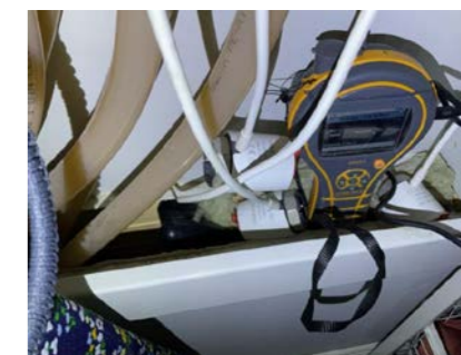
Fuktmåling i konstruksjonen mot bad.
