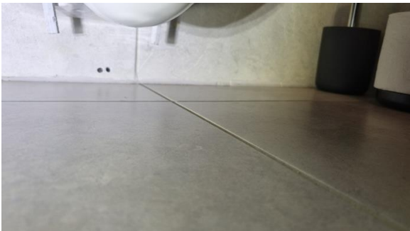
Drensåpning for synliggjøring av eventuelt lekkasjevann fra sisterner.
