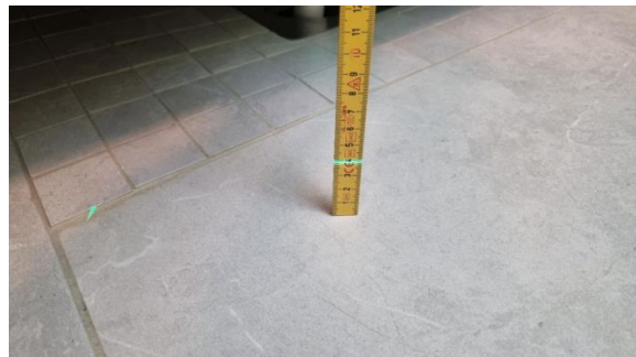
Gulvet er tilnærmet flatt.
