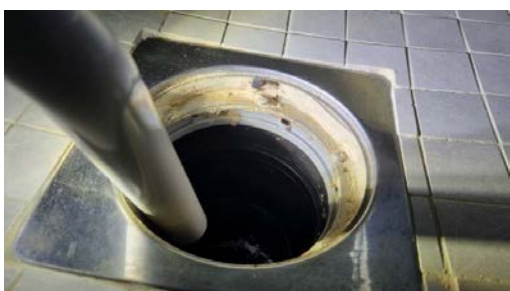
Kontroll av sluk.
