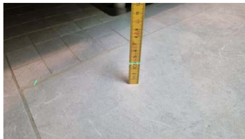
Gulvet er tilnærmet flatt.
