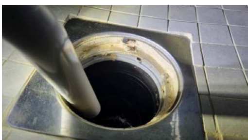
Kontroll av sluk.
