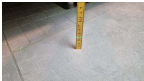
Gulvet er tilnærmet flatt.
