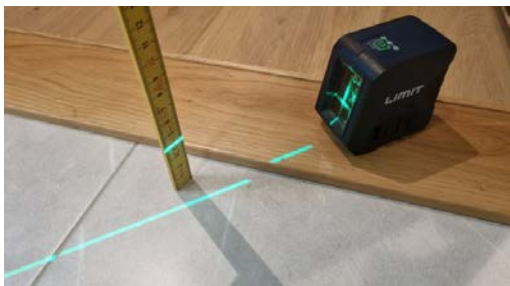
Kontroll av fall til sluk.
