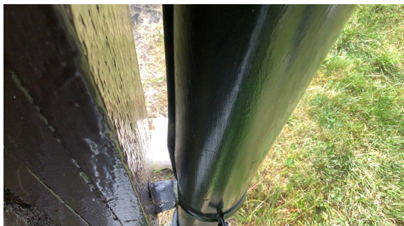
Frostsprengt nedløpsrør.
