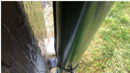
Frostsprengt nedløpsrør.
