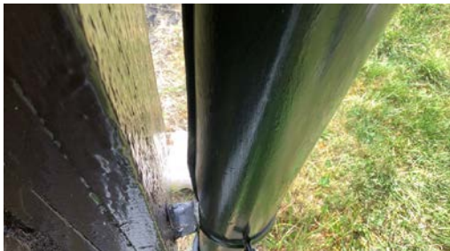
Frostsprenget nedløpsrør.
