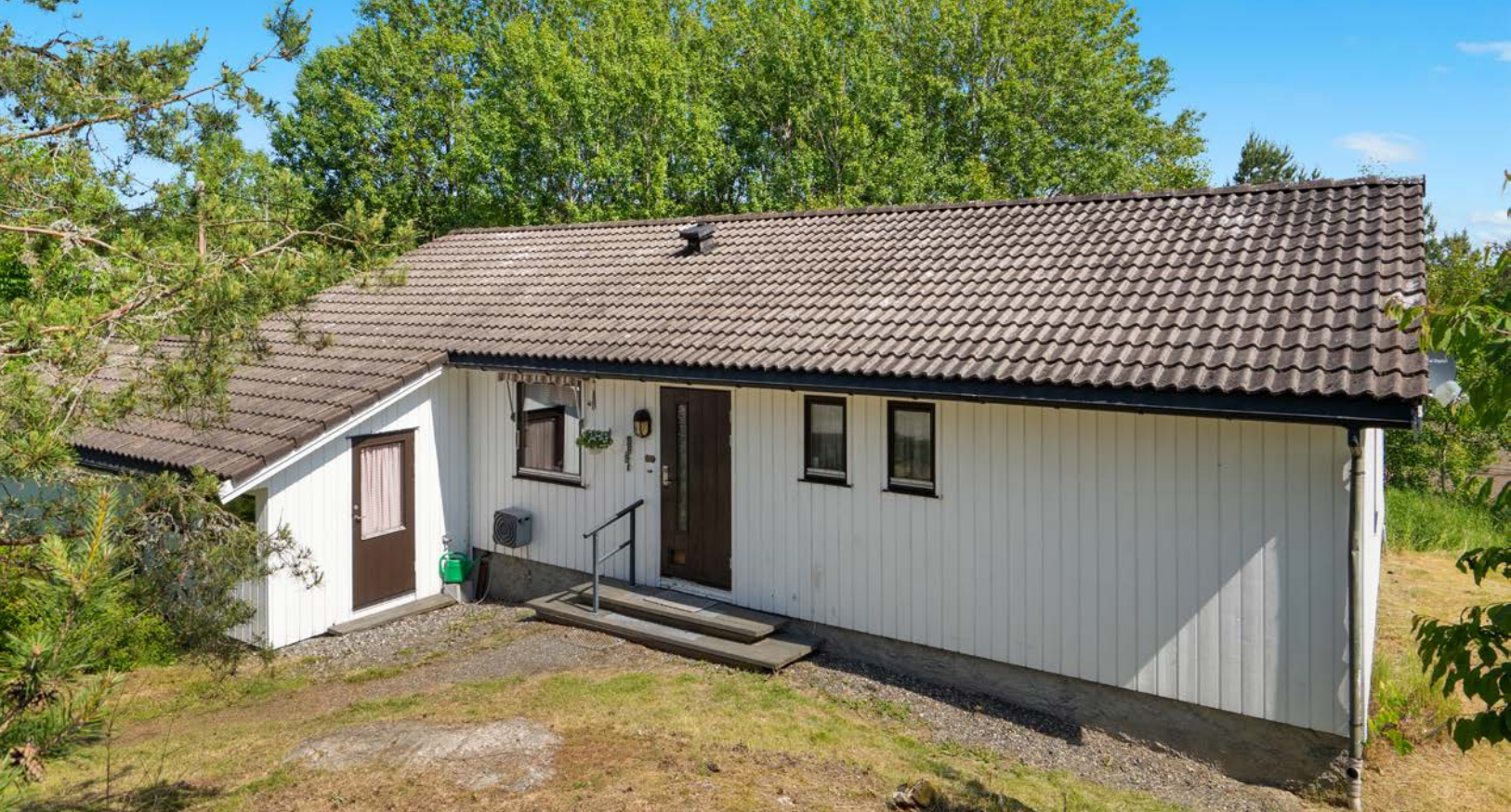
Boligen er bygget på en flate, bortsett fra et lite trinn fra kjøkken til vaskerom
