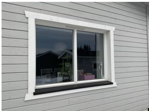
Vindu i 1. etg
