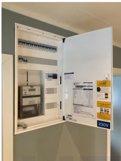
Sikringskap i gang.
