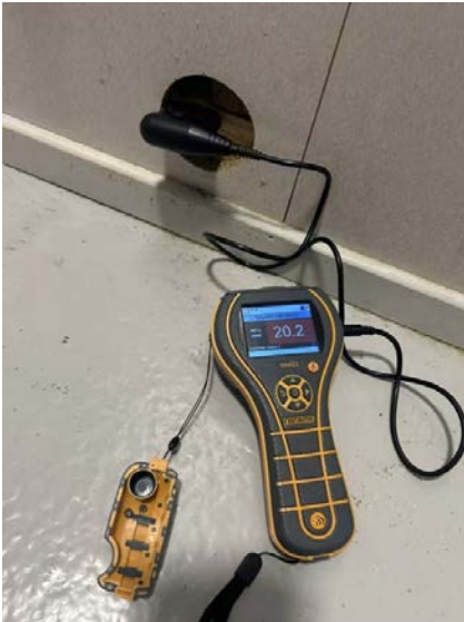
Fuktmåling i påforet vegg.
