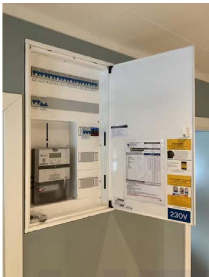
Sikringskap i gang.
