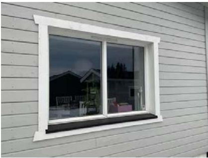
Vindu i 1. etg
