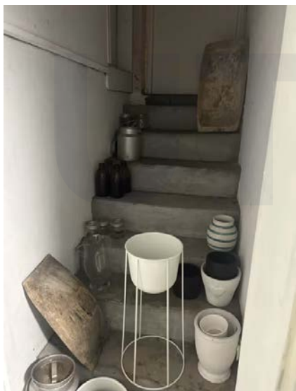
Trapp fra utvendig ned til kjeller.
