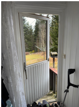
Dørblad tetter dårlig mot karm.
