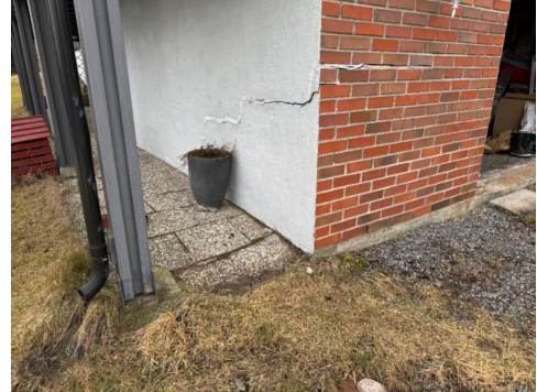
Store sprekker/setningskader
