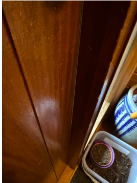
Dørblad tetter dårlig mot karm.
