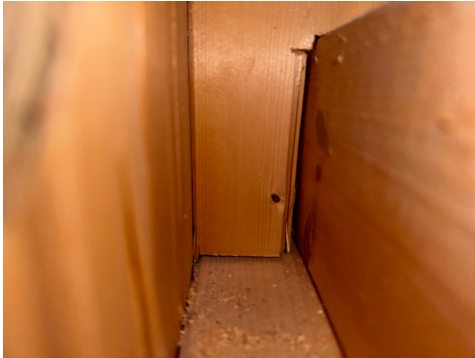
Bilde av svill/innside vegg
