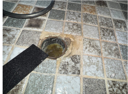
Utett rørgjennomføring i gulv (gammelt avløp fra badekar)
