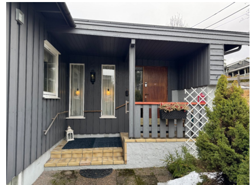
Trapp med skjevheter i front av balkongdør på soverom
