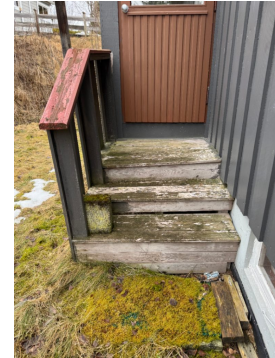
Trapp med skjevheter i front av balkongdør på soverom
