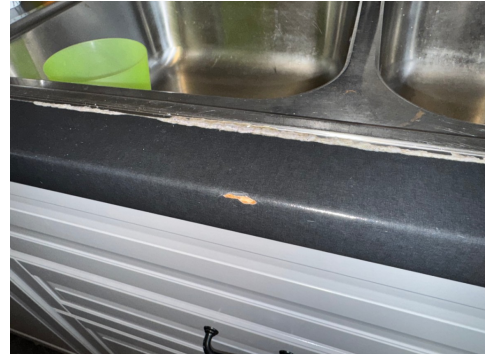
Skade i benkeplate
