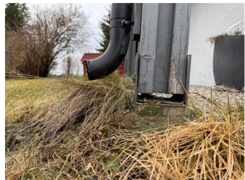
Bæresøyle i friluft (fundament har sunket)
