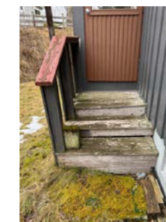
Trapp med skjevheter i front av balkongdør på soverom
