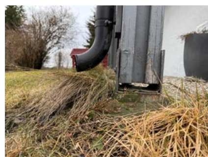
Bæresøyle i friluft (fundament har sunket)
