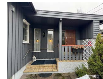
Trapp med skjevheter i front av balkongdør på soverom
