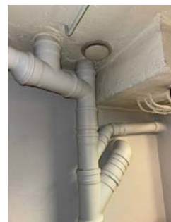
Toalettrommet har kun naturlig ventilasjon og ingen tilluftspalte dør e.l.
