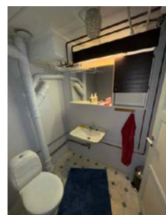
Toalettrommet har kun naturlig ventilasjon og ingen tilluftspalte dør e.l.
