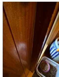
Dørblad tetter dårlig mot karm.
