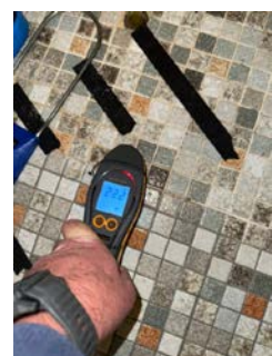
Utett rørgjennomføring i gulv (gammelt avløp fra badekar)
