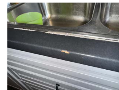
Skade i benkeplate
