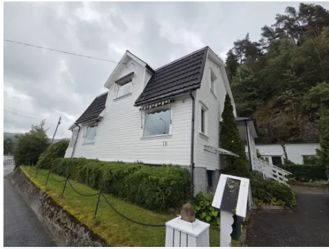
Rekkverk på fremsiden av boligen, mot vei.
