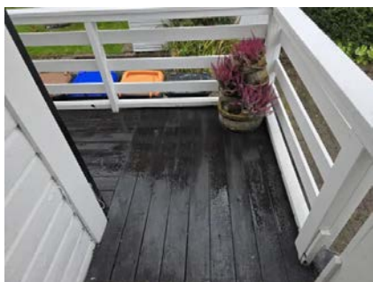
Terrasse ved inngangsparti.
