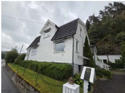
Rekkverk på fremsiden av boligen, mot vei.
