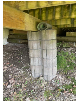
Noe skjevheter i søylepunkter ble registrert.
