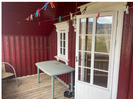
Balkongdør i 2. etg. står beskyttet under takoverbygg.
