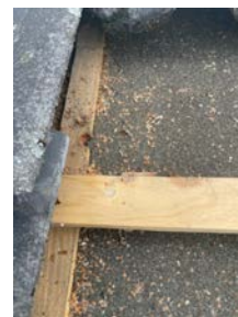
Lekter og sløyfer holder god kvalitet. Kontrollert ved ett tilfeldig sted.
