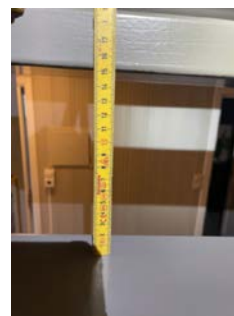
Åpning mellom spiler i trapp 12 cm
