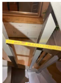
Åpning mellom spiler i trapp 12 cm
