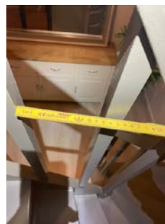
Åpning mellom spiler i trapp 12 cm
