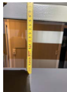
Åpning mellom spiler i trapp 12 cm
