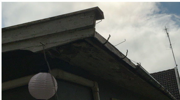
Råteskader
