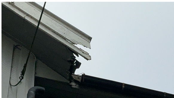
Råteskader.
