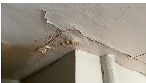
Fuktskader rundt pipe på loft.
