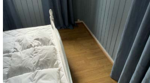
5 cm skjevheter i soverommet.
