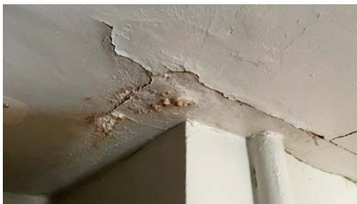
Fuktskader rundt pipe på loft.
