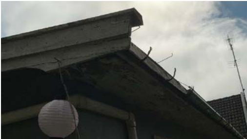
Råteskader
