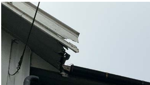
Råteskader.
