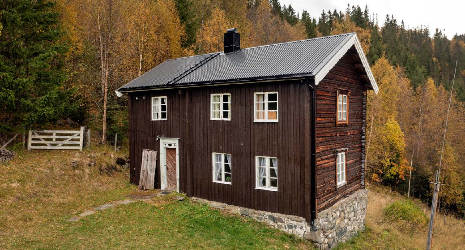
Våningshuset fra ca. 1890 - Nytt tak i 2017, for øvrig klart for rehabilitering
