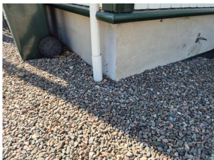
Vorteplast under terreng.
