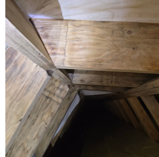
Bilde etter utbedring, sperrer pusset og smurt med soppdrepende middel.
