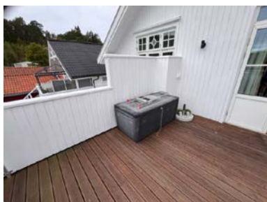
Kort avstand fra underkant av bordkledning til terrasse.
