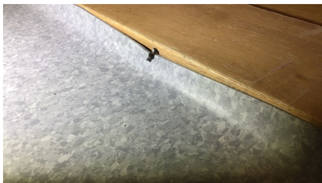
sprekk på belegg under dør
