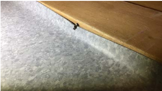
sprekk på belegg under dør
