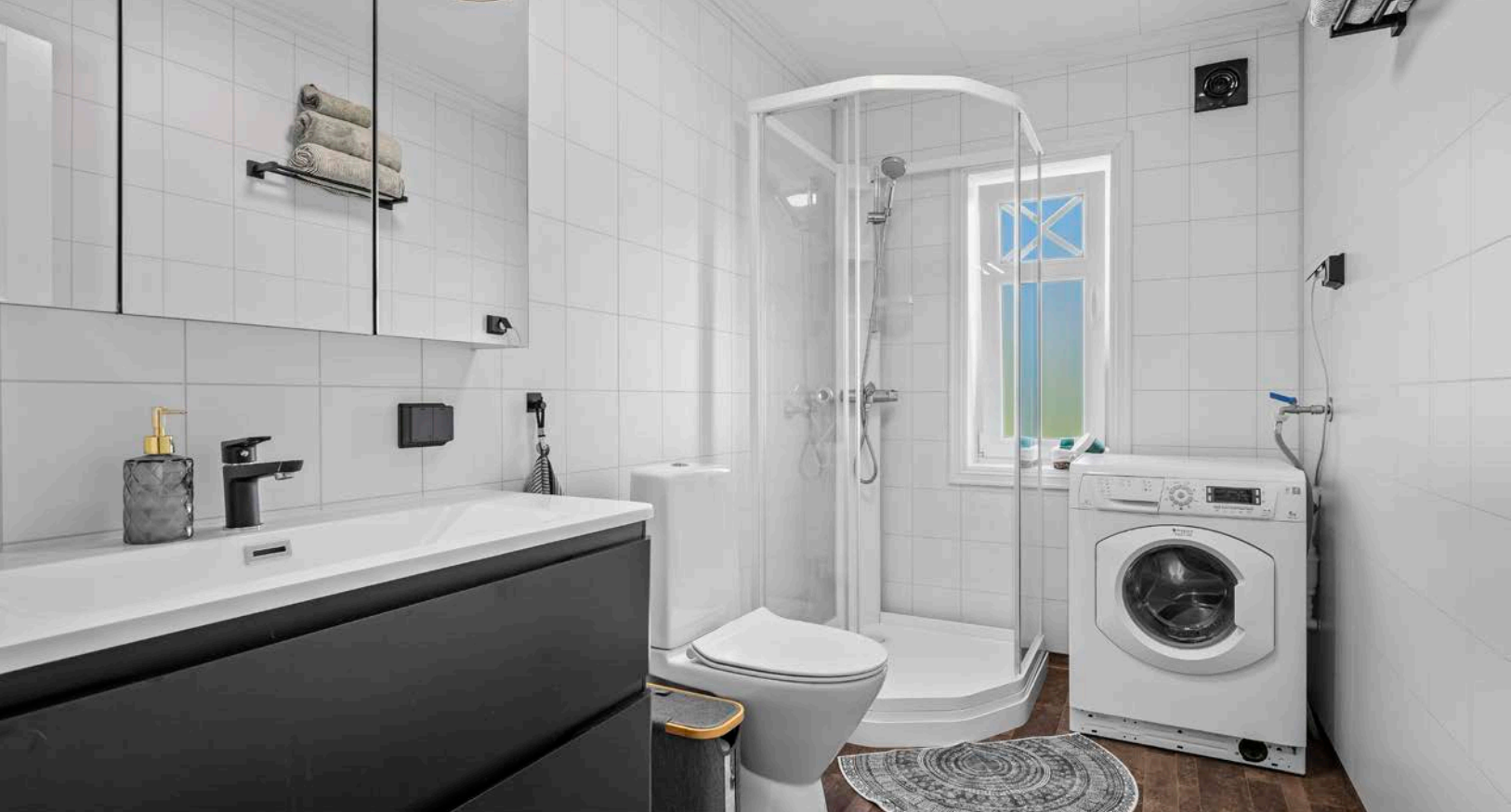
Badet er pusset opp med belegg på gulv og våtromsplater på vegg.
