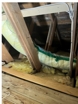
Utbedret isolering av kanaler etter befarng.
