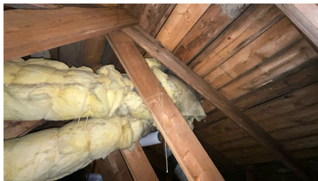
Kontroll rundt rørgjennomføringer.
