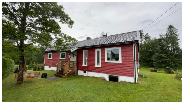
Besiktigelse av taktekke.
