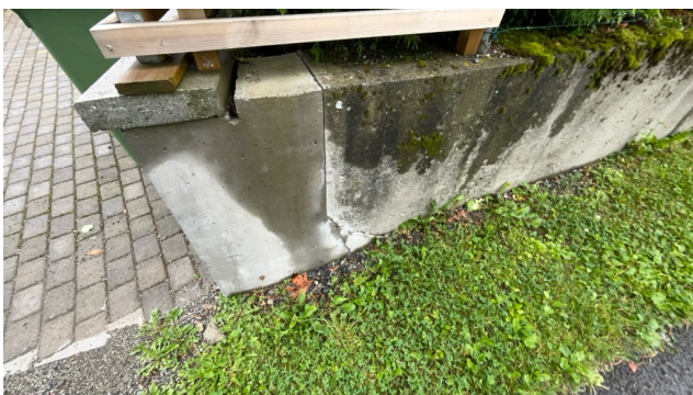
Besiktigelse av støttemur.
