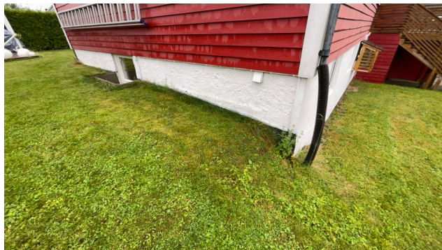
Kontroll av drenering/fuktsikring.
