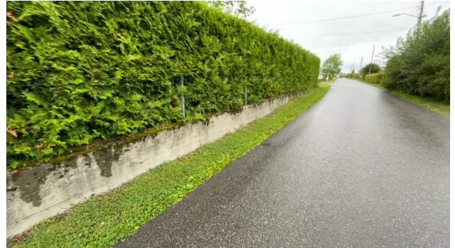
Besiktigelse av støttemur.
