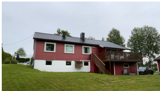
Besiktigelse av taktekke.
