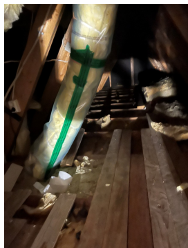
Utbedret isolering av kanaler etter befarng.
