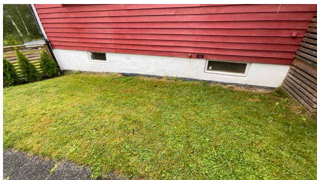
Kontroll av drenering/fuktsikring.
