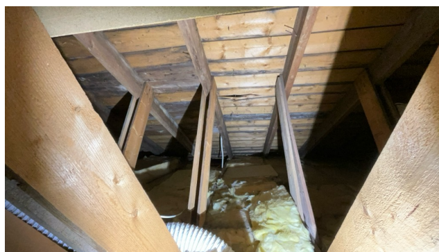
Begrenset lufting på takfot.
