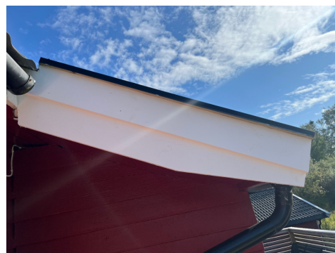
Byttet vindskie etter utført befaring.
