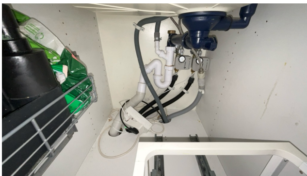
Besiktigelse av røropplegg.
