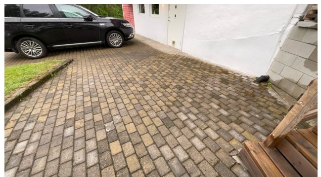
Mindre fall mot bygning.
