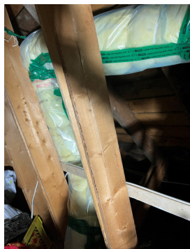
Utbedret isolering av kanaler etter befarng.
