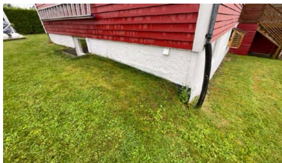
Kontroll av drenering/fuktsikring.
