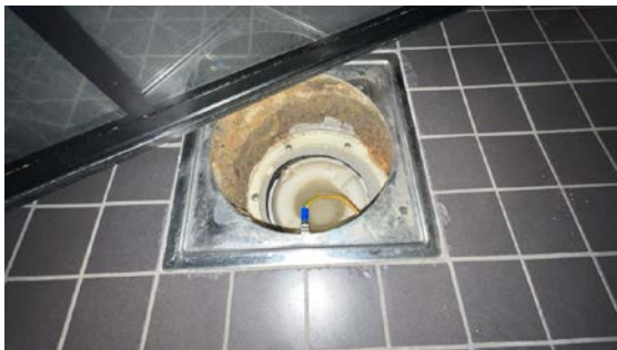
Kontroll av sluk.
