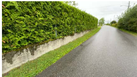
Besiktigelse av støttemur.
