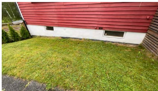
Kontroll av drenering/fuktsikring.
