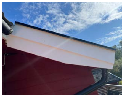
Byttet vindskie etter utført befarung.
