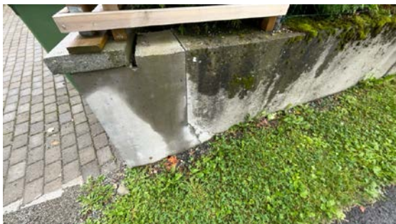
Besiktigelse av støttemur.
