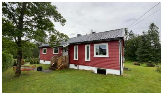
Besiktigelse av taktekke.
