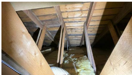
Begrenset lufting på takfot.
