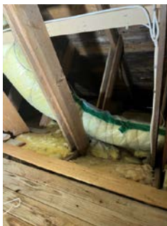
Utbedret isolering av kanaler etter befarng.
