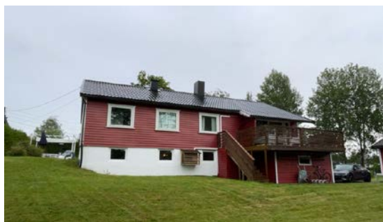
Besiktigelse av taktekke.
