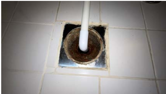
Kontroll av sluk.
