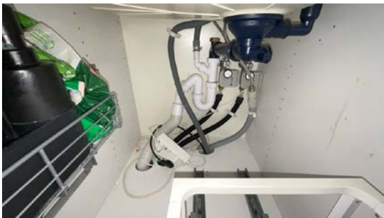
Besiktigelse av rørøpplagg.
