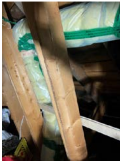
Utbedret isolering av kanaler etter befarng.
