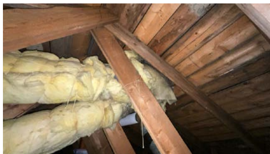
Kontroll rundt rørgjennomføringer.
