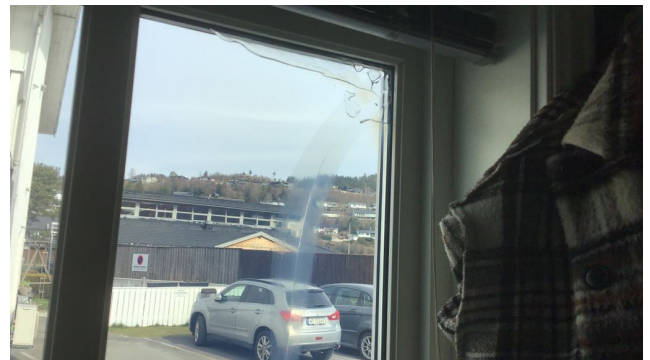
Vindu på bad
