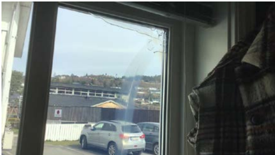
Vindu på bad
