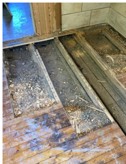
Enkelte gulv og vegger er påbegynt revet.
