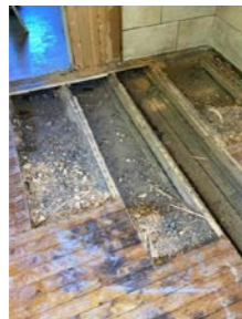
Enkelte gulv og vegger er påbegynt revet.
