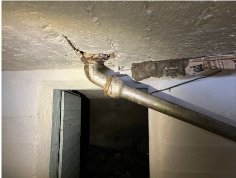
Avløpsrør i støpejern.
