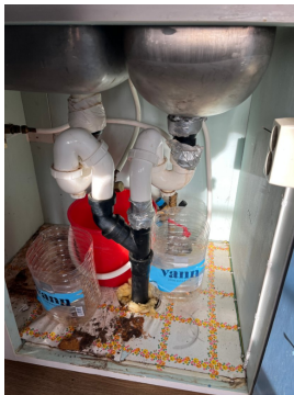
Provisorisk tetting av avløpsrør.
