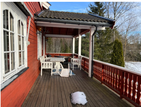
Delvis overbygget veranda.
