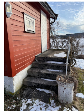
Støpt trapp med stål rekkverk.
