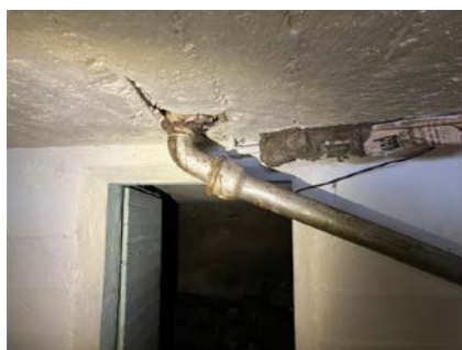
Avløpsrør i støpejern.
