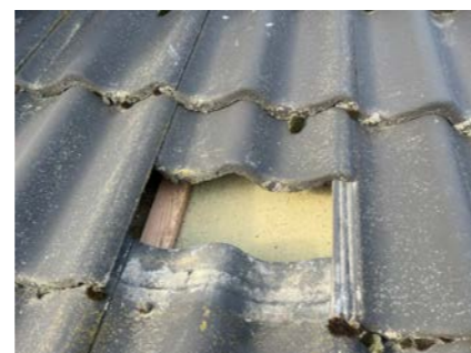
Betongtakstein med undertaksplater.
