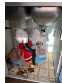
Provisorisk tetting av avløpsrør.
