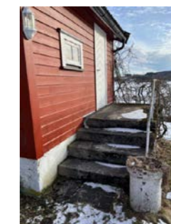
Støpt trapp med stål rekkverk.
