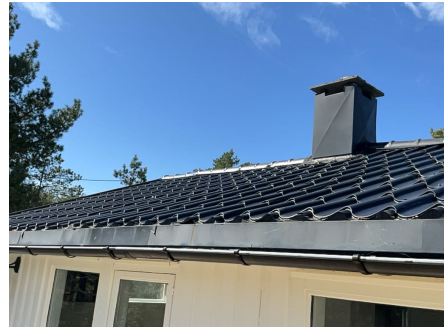
Del av taktekkning.
