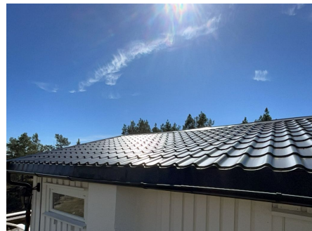
Del av taktekkning.
