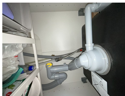
Del av rør til vann.
