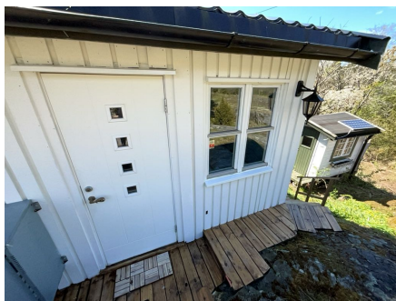
Inngangsdør inn til soverom.
