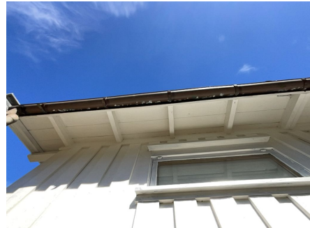
Del av takkonstruksjon.
