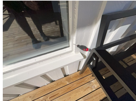
Stikk kontroll på vinduer er utført.
