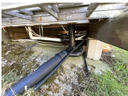
Del av rør til avløp.
