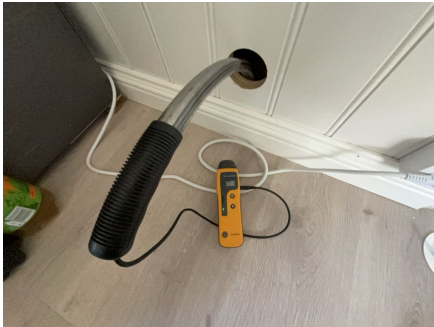
Hull for kontroll av fukt.
