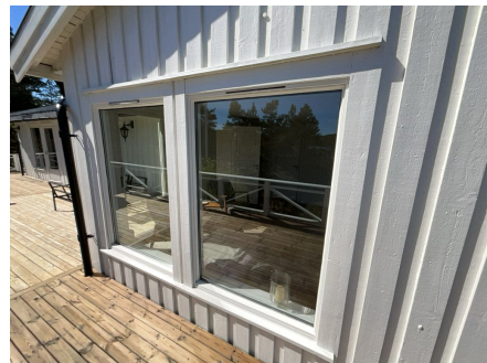
Eksempel på vindu i yttervegg.
