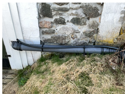
Del av rør til avløp.
