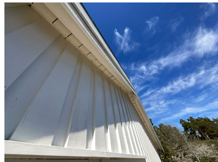
Del av takkonstruksjon.
