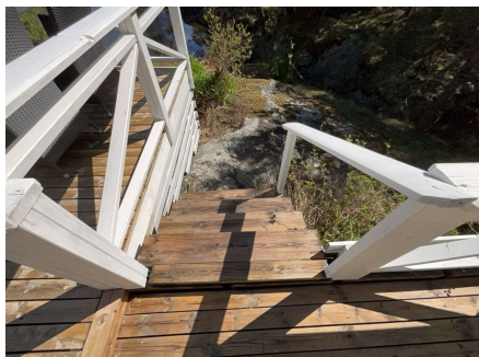
Trapp ned fra terrasse.
