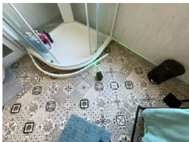
Målt fall på gulv. Del av gulv.
