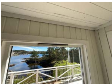
Eksempel på montert ventil i vindu.
