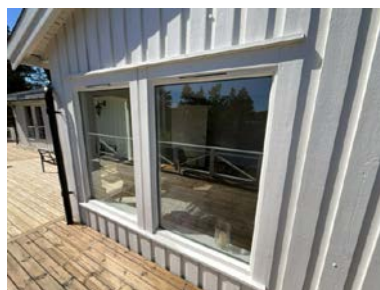
Eksempel på vindu i yttervegg.
