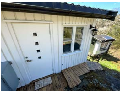
Inngangsdør inn til soverom.
