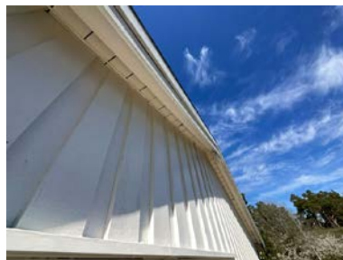
Del av takkonstruksjon.
