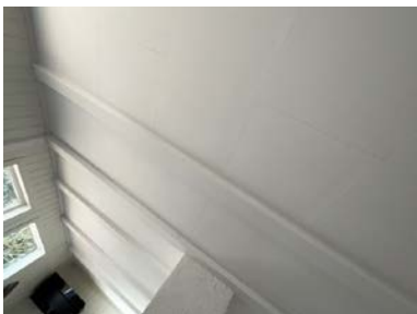
Tak sett fra innsiden.
