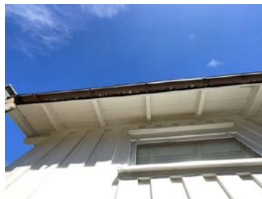
Del av takkonstruksjon.
