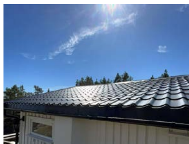
Del av taktekking.
