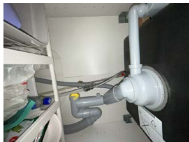
Del av rør til vann.
