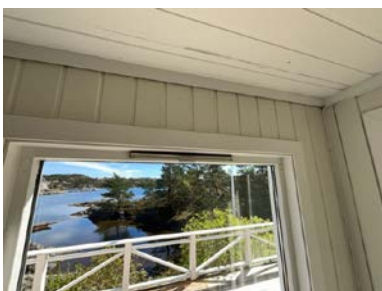
Eksempel på montert ventil i vindu.
