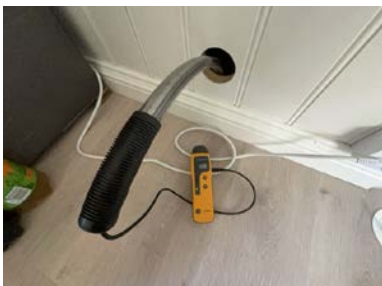
Hull for kontroll av fukt.
