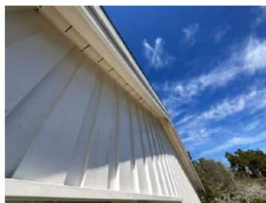
Del av takkonstruksjon.
