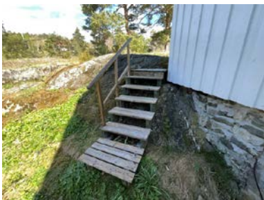
Trapp mellom terreng.
