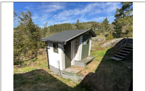
Bod oppført på eiendommen, men denne er ikke godkjent. Denne er ikke beskrevet mer i denne rapport.
