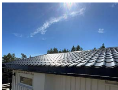
Del av taktekking.
