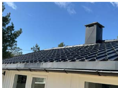
Del av taktekking.
