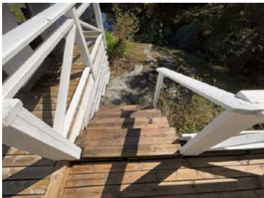
Trapp ned fra terrasse.
