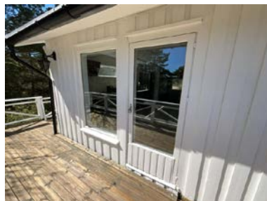
Terrassedør inn til kjøkken.
