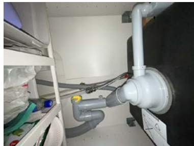
Del av rør til vann.
