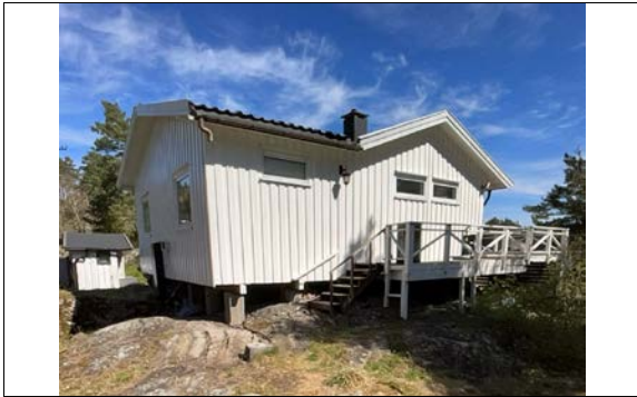
Hytte oppført på eiendommen.
