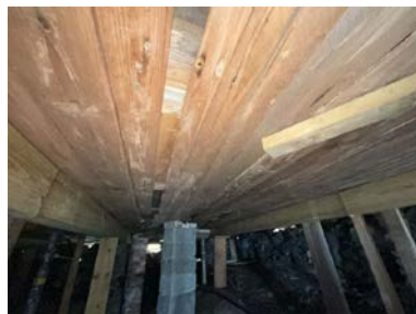
Del av etasjeskille sett fra undersiden.
