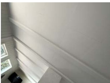
Tak sett fra innsiden.
