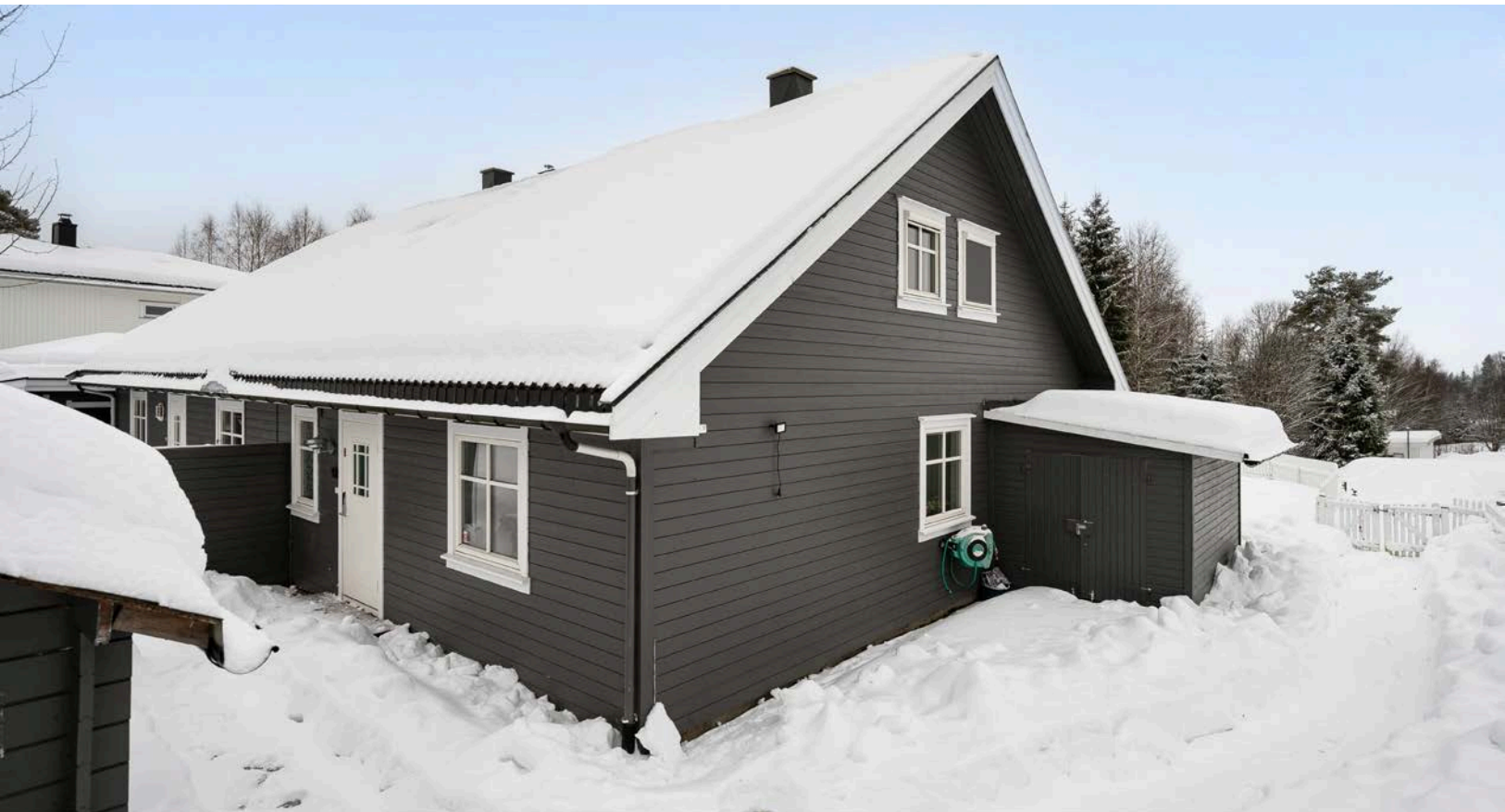
Boligen har inntilbygget lagerbod på 8m 2 med utvendig adkomst. Eiendommen er også bebygd med en frittliggende utebod som ikke er oppmålt.
